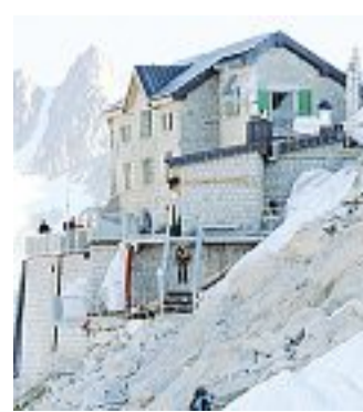
Panorami Il fascino dei rifugi
